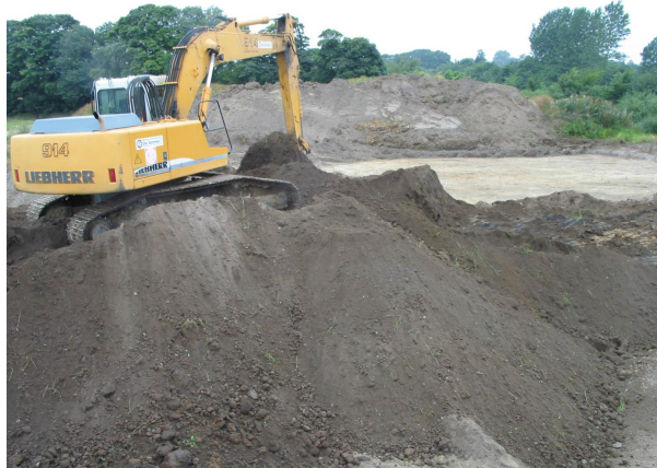
Fig. 4. Mulden afgraves af gravemaskine
