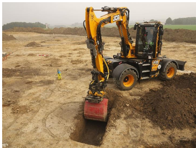
Grubesnitning med 12 t gravemaskine.
