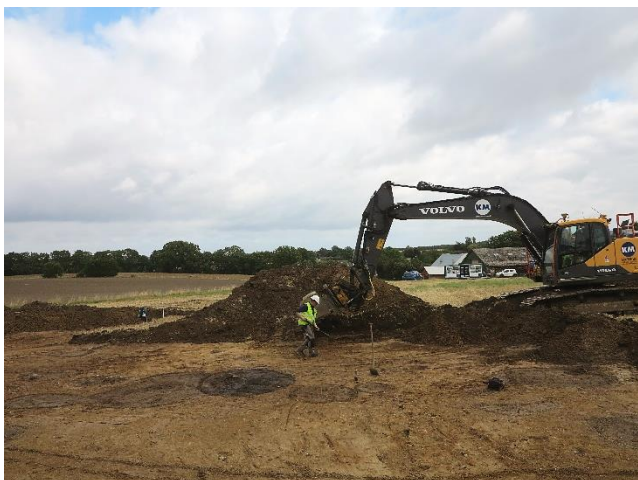
Fladeskovling og muldafrømning med 25 t gravemaskine.
